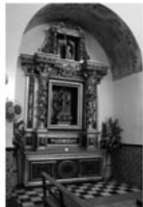
RETABLO Y RESTAURACION DE BOVEDA CAPILLA DEL ROSARIO. SAN ANTONY DE PORTMANY (EIVISSA)
